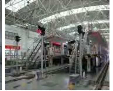
Inspection Center 检修中心
