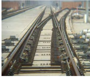
Rail 物理轨道
